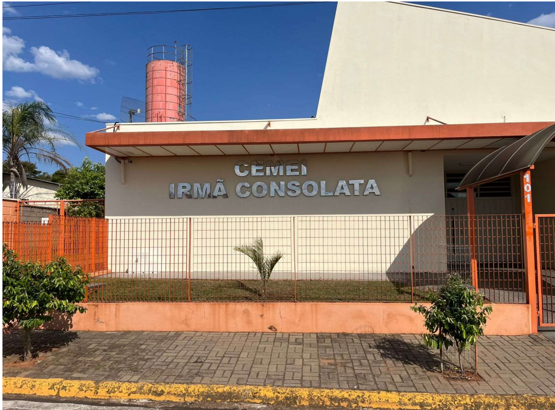
Fachada da CEMEI Irmã Consolata.
